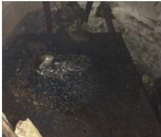
Puits de pompage identifié dans le sous-sol du bâtiment 12 (traces d'hydrocarbures sur la seconde photo)
