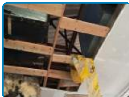
D.O. n° 23 sur Plafond Plaques amiante-ciment
