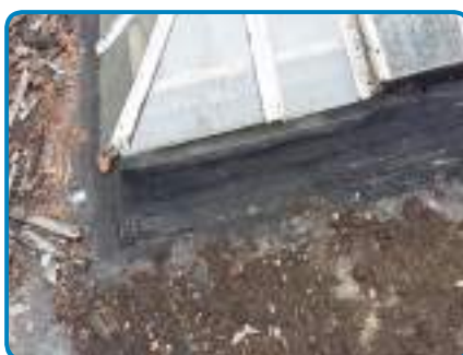
D.O. n° 11 sur Plafond Plaques amiante- ciment
