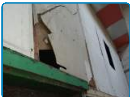
D.O. n° 13 sur Mur(s) Plaques amiante-ciment Peinture / B
