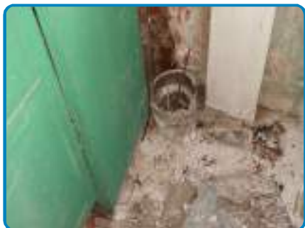
D.O. n° 12 sur Conduit(s) de fluide Amiante ciment
