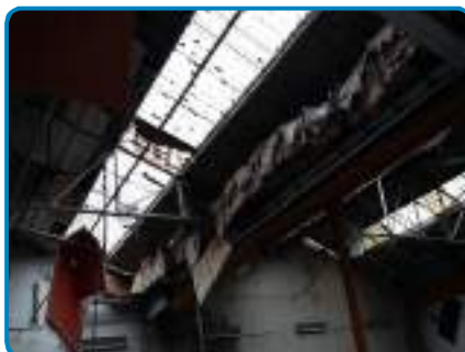
D.O. n° 51 sur Plafond Plaques amiante-ciment Peinture
