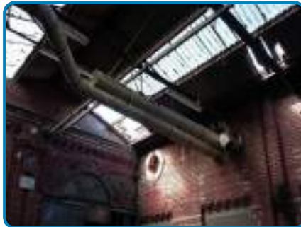
D.O. n° 11 sur Plafond Plaques amiante- ciment
