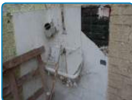
D.O. n° 35 sur Mur(s) Plaques amiante-ciment / BC
