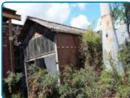
D.O. n° 33 sur Toiture Plaques amiante- ciment / Toiture lo
