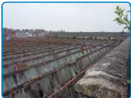
D.O. n° 13 sur Mur(s) Plaques amiante-ciment Peinture / B
