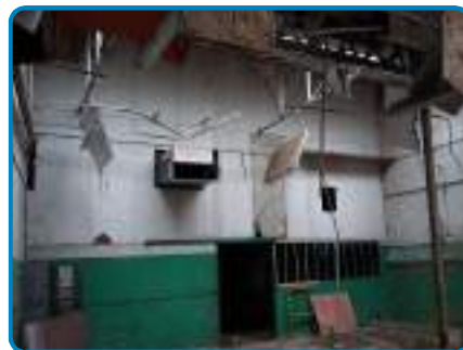
D.O. n° 4 sur Mur(s) Plaques amiante-ciment Peinture / B
