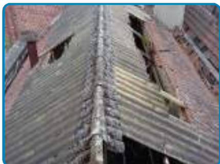
D.O. n° 55 sur Toiture ( faitage ) Plaques amiante-ciment
