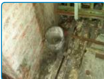
D.O. n° 48 sur Conduit(s) de fluide Amiante ciment Peinture
