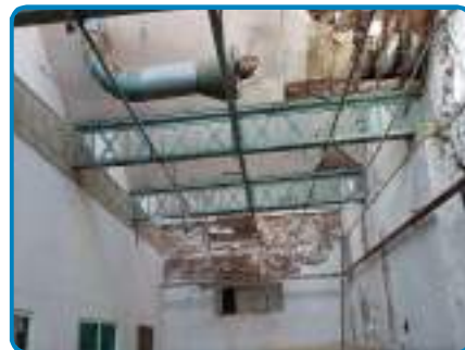
D.O. n° 37 sur Plafond Plaques amiante-ciment
