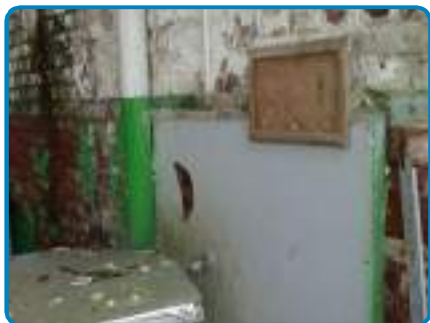
D.O. n° 18 sur Mur(s) Plaques amiante-ciment / D
