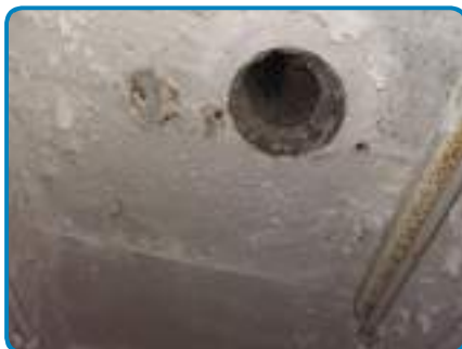
D.O. n° 5 sur Conduit(s) de ventilation Amiante ciment
