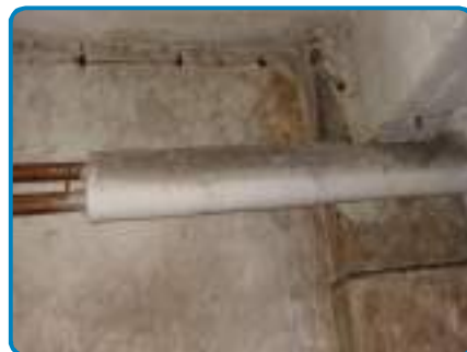
D.O. n° 6 sur Mur(s) Plaques amiante-ciment Peinture / D
