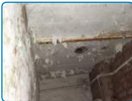
D.O. n° 7 sur Conduit(s) de ventilation Amiante ciment
