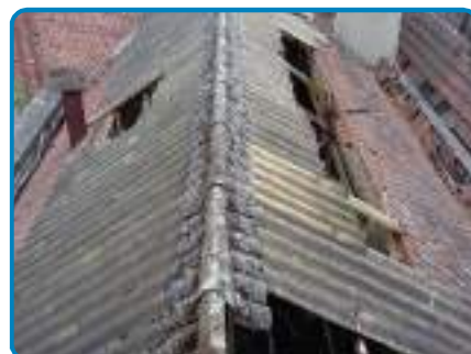
D.O. n° 37 sur Plafond Plaques amiante-ciment
