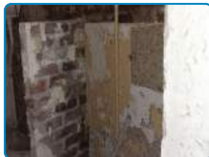
D.O. n° 6 sur Mur(s) Plaques amiante-ciment Peinture / D
