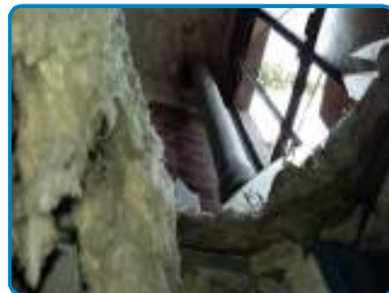
D.O. n° 46 sur Conduit(s) de fluide Amiante ciment
