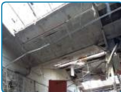
D.O. n° 14 sur Plafond Plaques amiante-ciment
