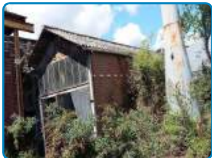
D.O. n° 44 sur Toiture Plaques amiante- ciment
