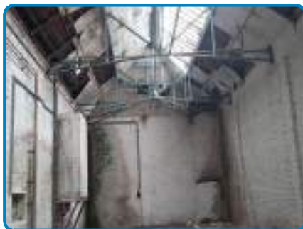
D.O. n° 1 sur Plafond Plaques amiante-ciment
